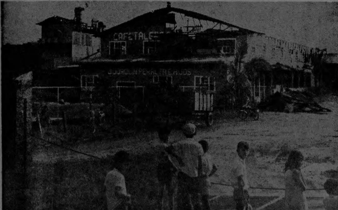
Parte de lo poco q' quedó de las instalaciones de la Cafetalera San Isidro son captadas en esta gráfica que se tomó en horas de la mañana de antier en San Isidro de El General.
